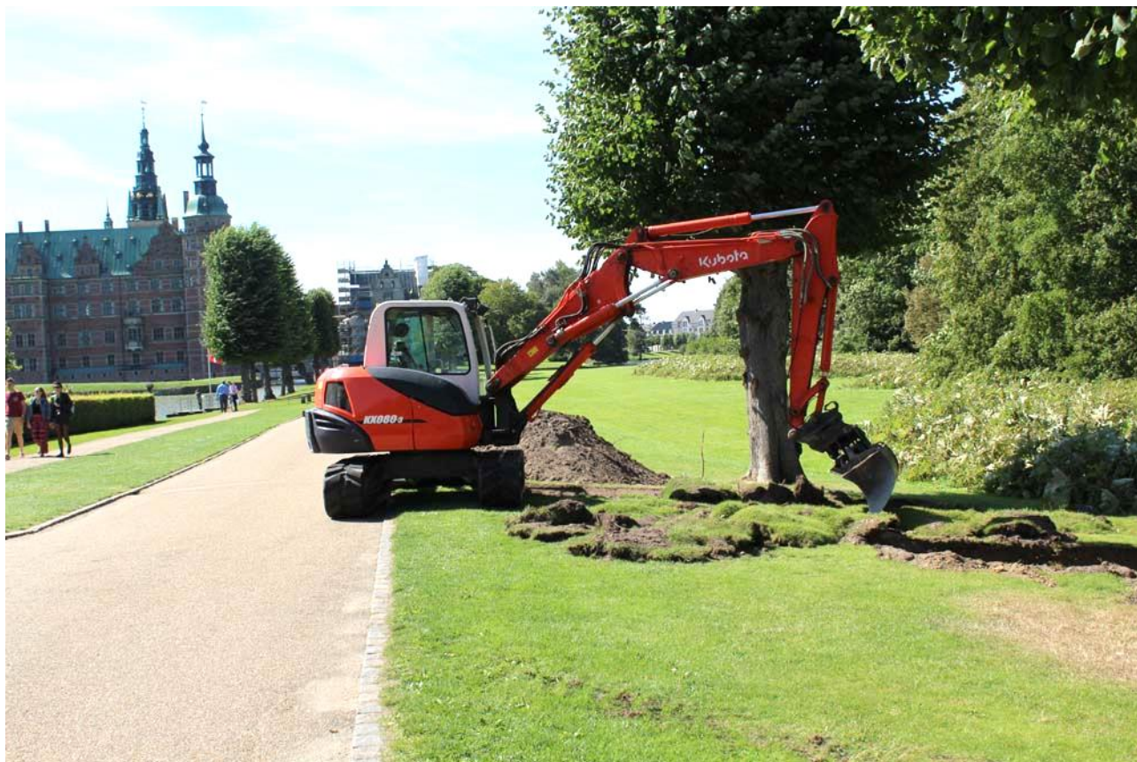
Udgravning i slotsparken ved Frederiksborg Slot.
