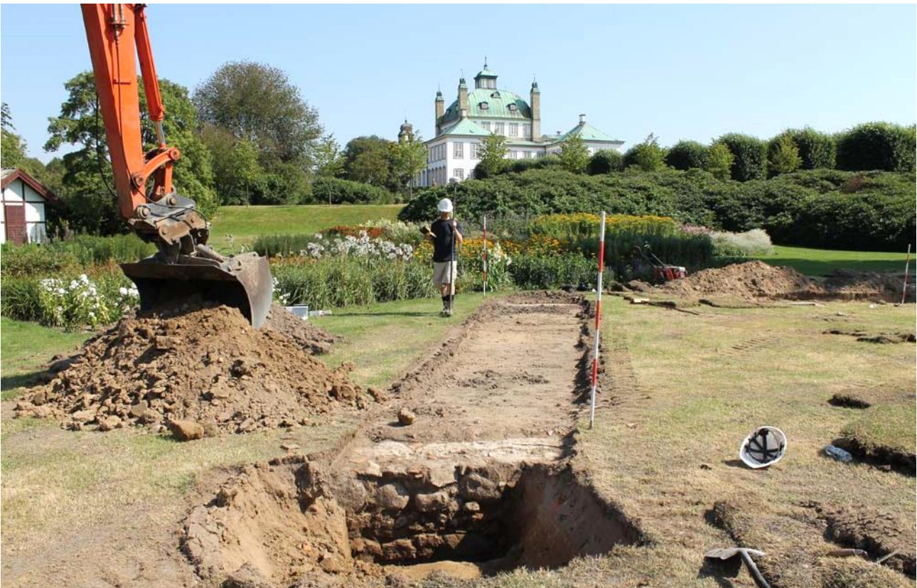
Fundamentet til fasanhuset ses i forgrunden og Fredensborg Slot i baggrunden.
