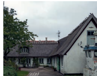
Bevares Østergade 20 indgår i museets faciliteter og udstilling samt er mødested for museumsforeningen.
