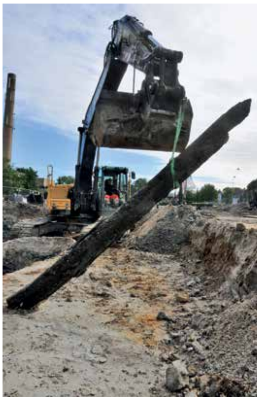
En af egetammerne løftes op fra udgravningen ved Kulturhavnen.
