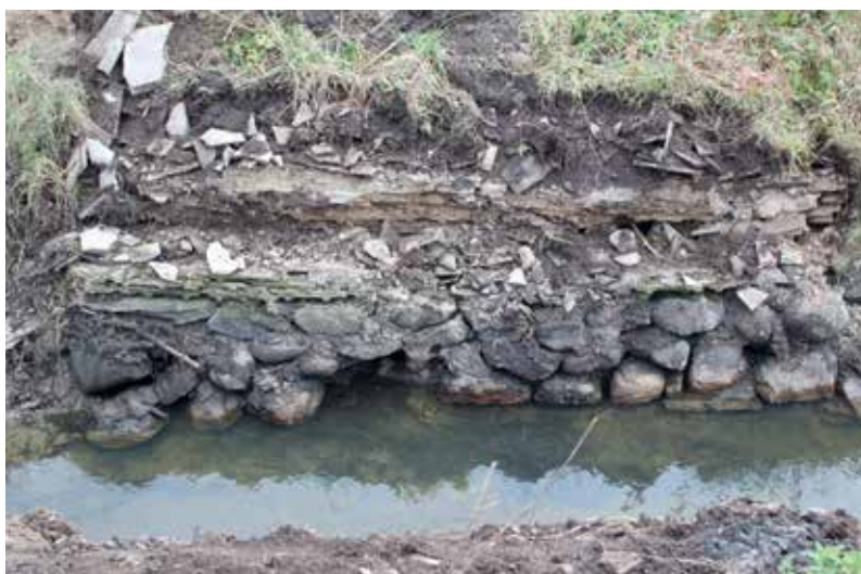
Brofundamentet med den ældste kampestensfase nederst.
